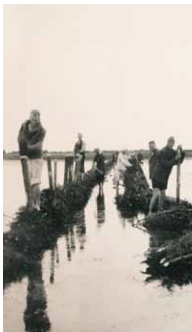
Hestehullet. Et arbejdsløshedsprojekt i 1934 byggede en dæmning over lagunen med det frygtede hestehul, så det blev nemmere at komme fra Lyngborgen ned til stranden. Dæmningen bruges stadig.
