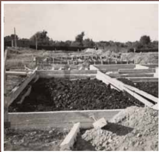
Første fundament på bar mark.
